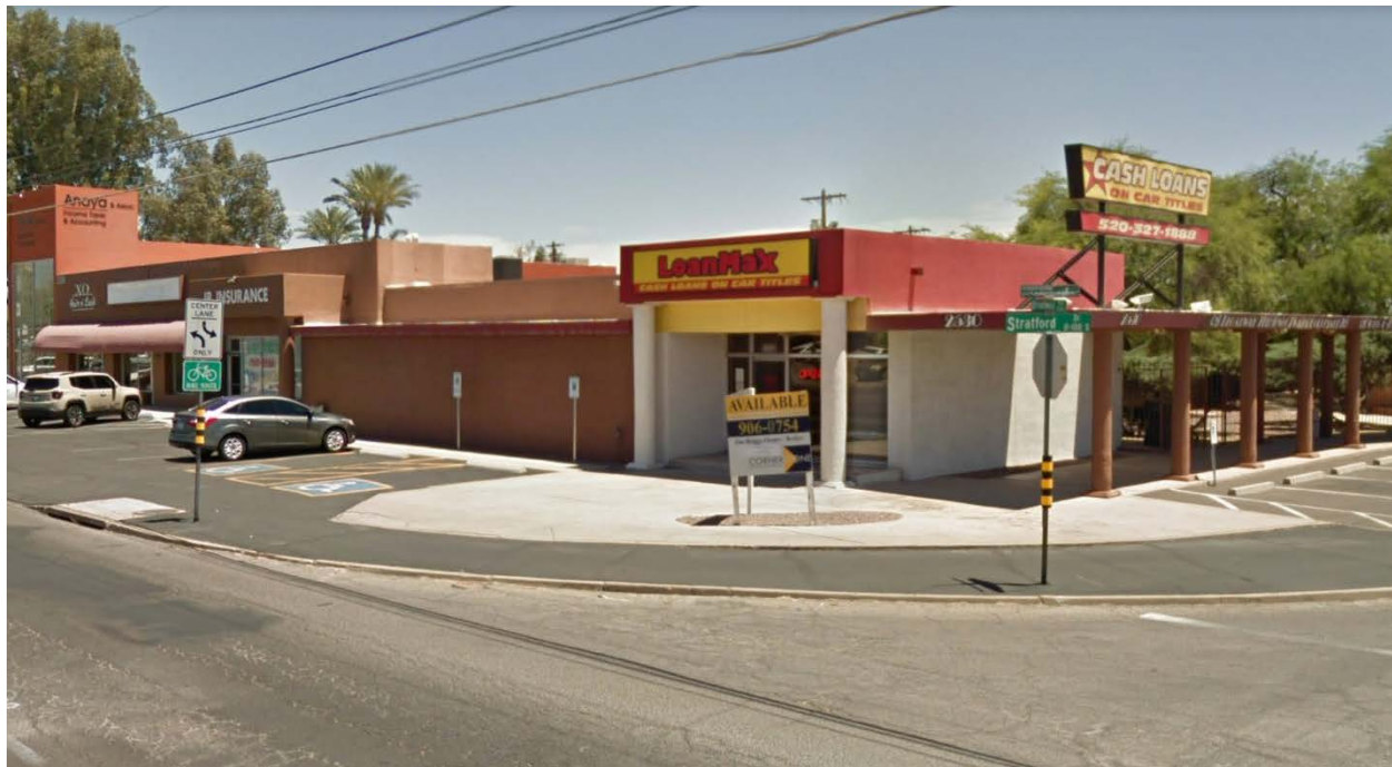
Fig. 26. 2530 E. Broadway Blvd. Photo: Google, 2017.
